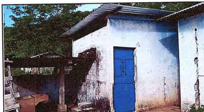
Foto 4: Se instaló nuevo techo y puerta de la cocina.
